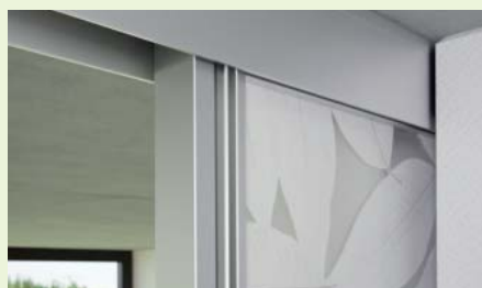
Die Türflügel verschwinden einfach in Wandtaschen.
